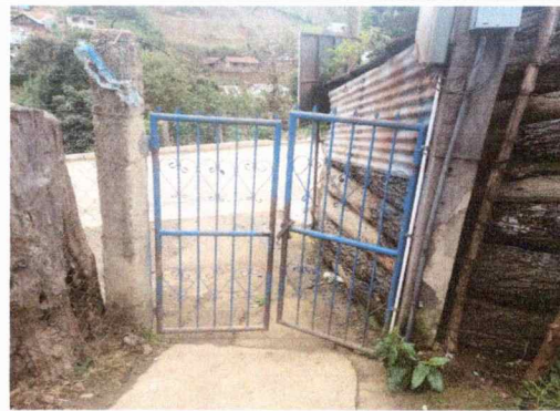
Foto 2: SUSTITUCION DE TECHO POR DETERIORO
