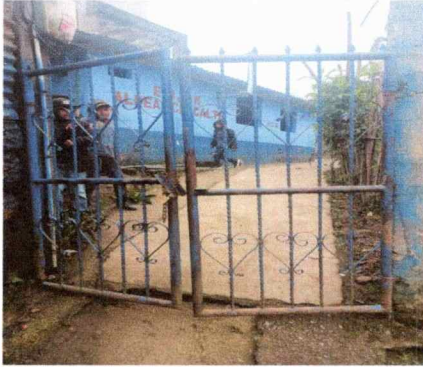
Foto 1: SUSTITUCION DE PORTON POR DETERIORO
